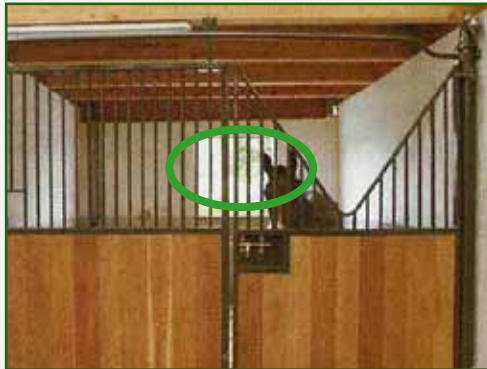
Afbeelding 60: Toegangsvenster tot de etensbak
