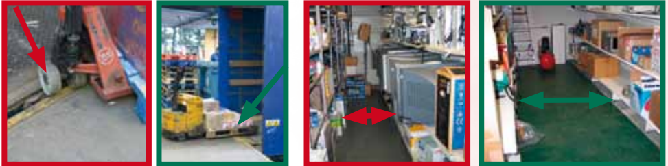
La présence de « lèvre » au niveau des niveleurs de quai ou encore de plaque de chargement évite les discontinuités entre le quai et le camion, sources d'efforts inutiles et de risques de chutes.
