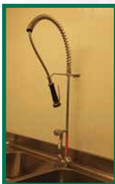
Le système de poignée et gachette incorporée à la douchette réduit les mouvements du poignet lors de l'utilisation du robinet. Le système de blocage réduit encore la durée de la force à appliquer
