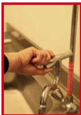
Le système de poignée et gachette incorporée à la douchette réduit les mouvements du poignet lors de l'utilisation du robinet. Le système de blocage réduit encore la durée de la force à appliquer
