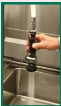
Le système de poignée et gachette incorporée à la douchette réduit les mouvements du poignet lors de l'utilisation du robinet. Le système de blocage réduit encore la durée de la force à appliquer
