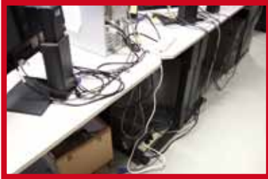
Le respect des dimensions des surfaces de circulation ainsi que leur rangement évite des chutes ou heurts désagréables.
