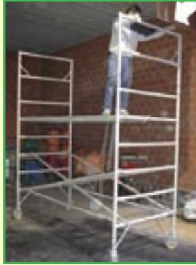
Travailler sur une échelle entraîne un risque de chute de hauteur. En utilisant un échafaudage mobile, le risque de chute de hauteur est toujours présent, mais la probabilité de chuter est bien moindre.
