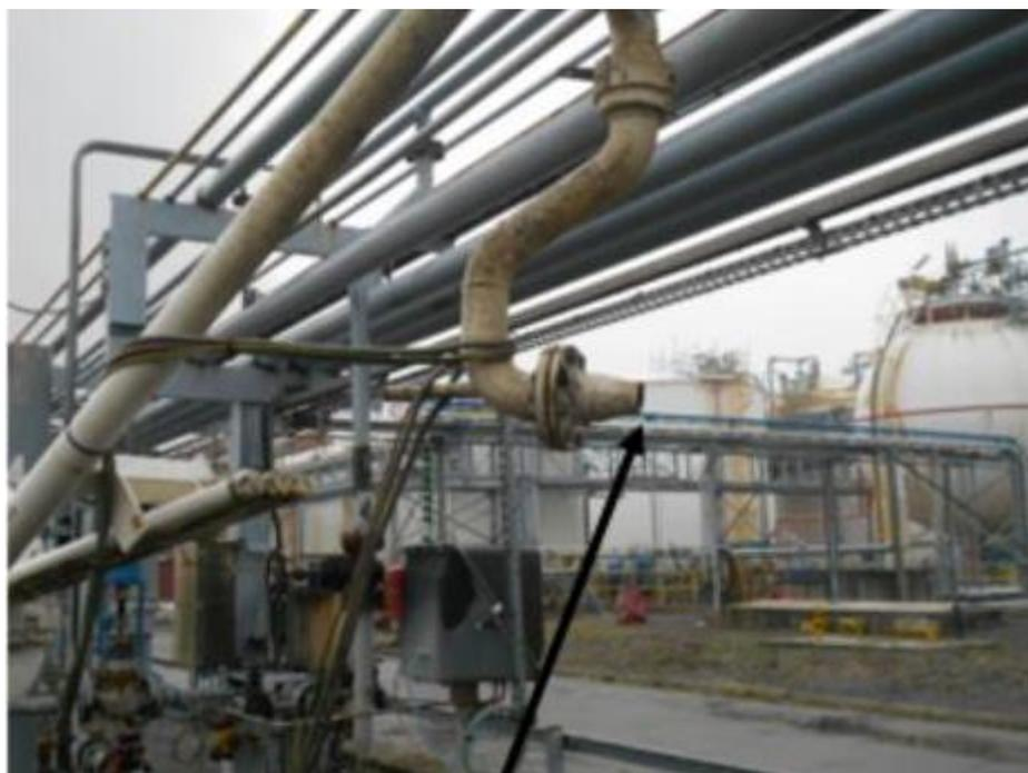
Avec la fermeture des vannes vers les bras de chargement, la grande libération est arrêtée mais du produit restant continue à s'écouler encore pendant un moment de la partie de la tuyauterie en aval des vannes d'isolement. Pendant le déplacement, les ridoirs ont fermés les vannes de fond des quatre wagons.
